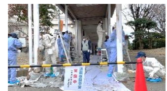
校舎の通用口鉄柱を塗装
