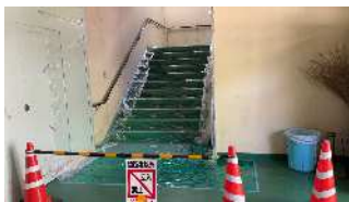
【HR棟 階段を補修してきれいになる】
