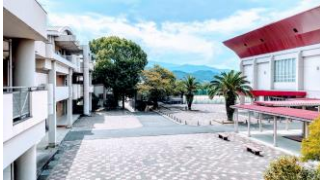
【グラウンドに続くメイン通路】
